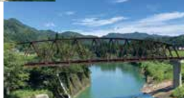
完成了恢復施工的 第七只見川橋樑
